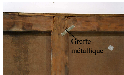
Fig.7 : détail du châssis avant remplacement, détail d'une ancienne restauration par greffe
