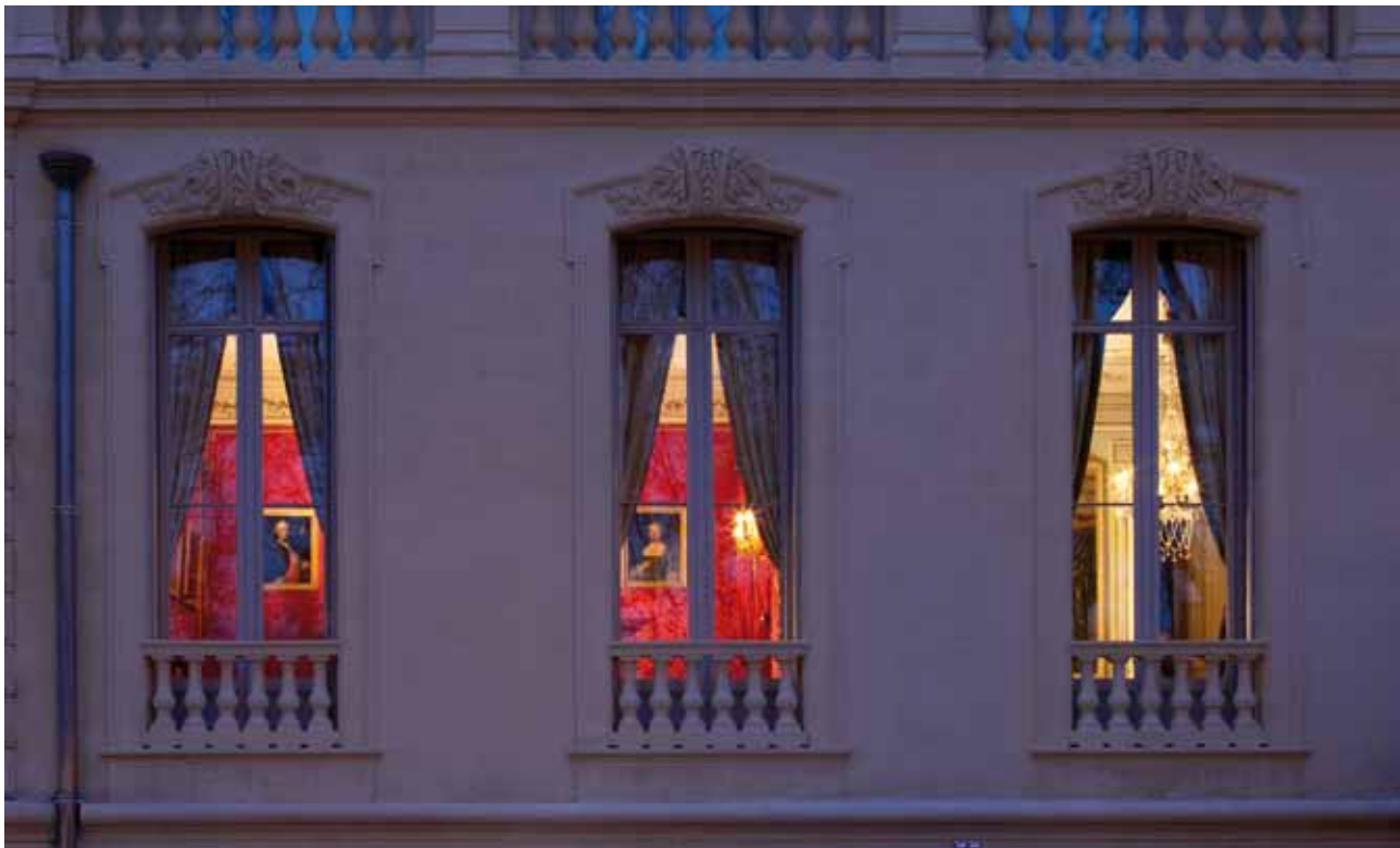
Vue de la façade de l'Hôtel Cabrières-Sabatier d'Espeyran
