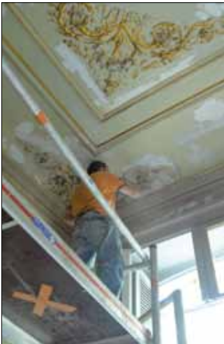
Restauration des plafonds
