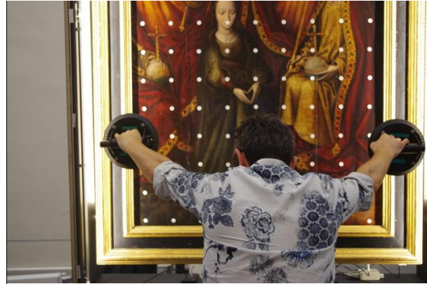
Pose du verre sur les deux faces de la chambre climatique, par Olivier Chassagne, responsable de l'équipe technique du musée Fabre
